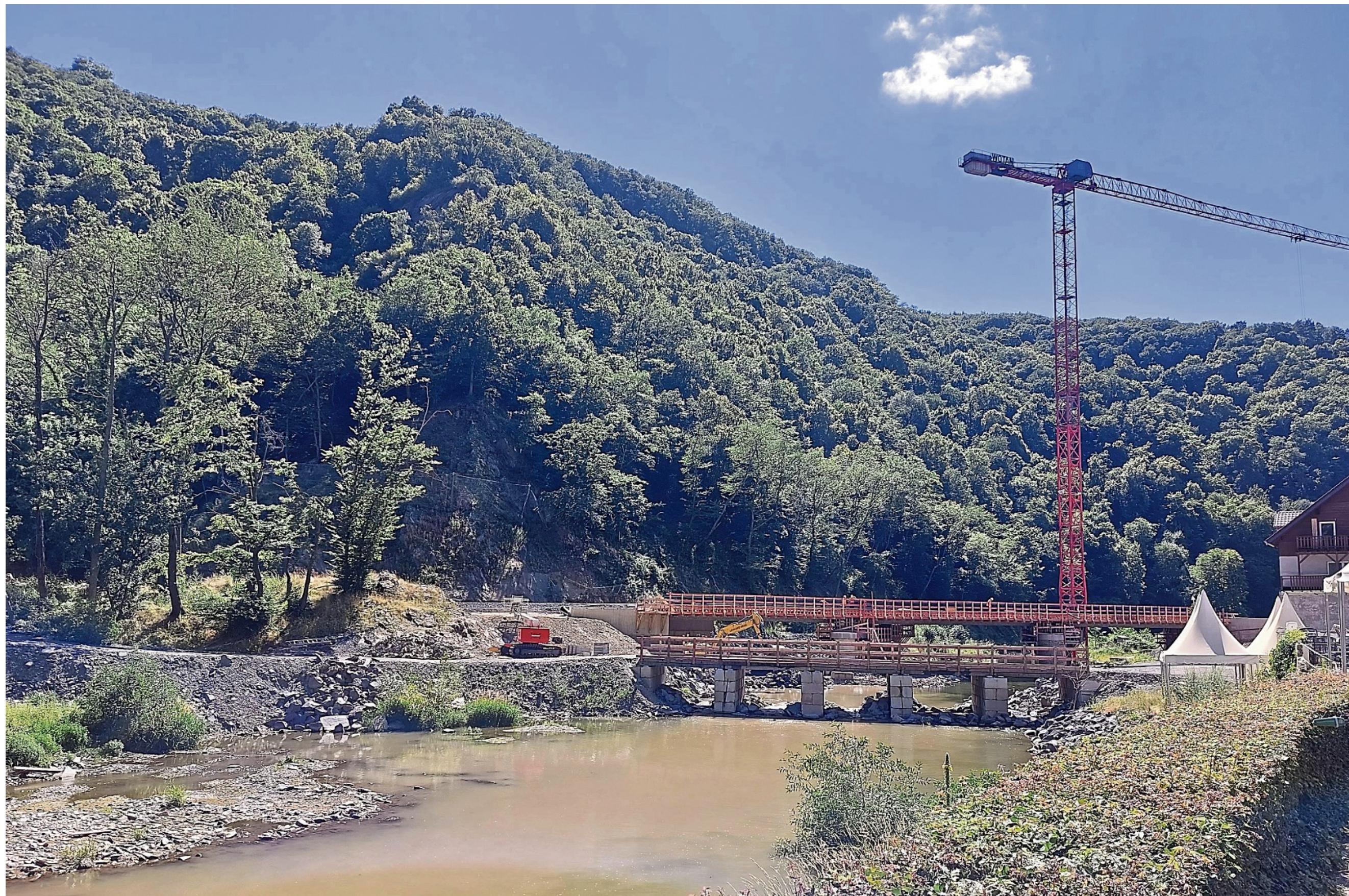
Der Wiederaufbau geht unterschiedlich schnell voran, es fehlen vor allem noch zahlreiche Brücken.
